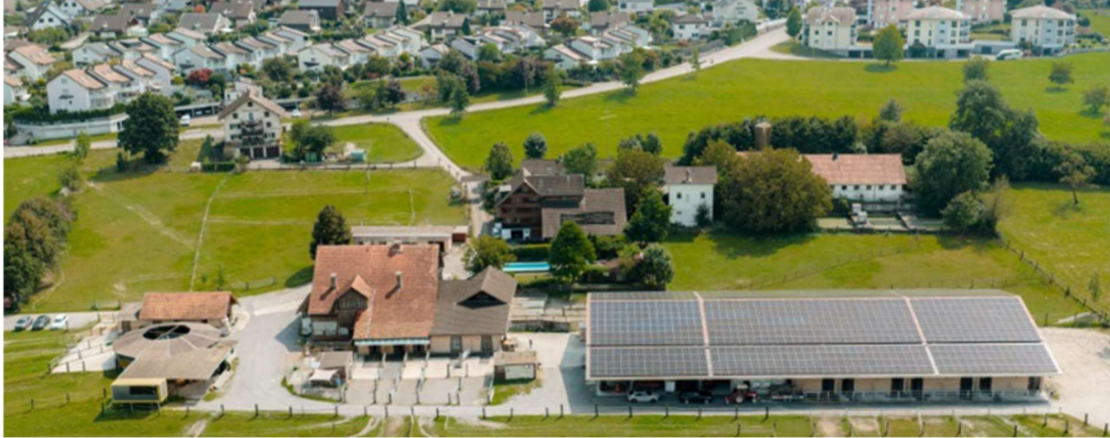
PV-Anlage auf dem Dach der Reithalle (69m Firstlänge)
