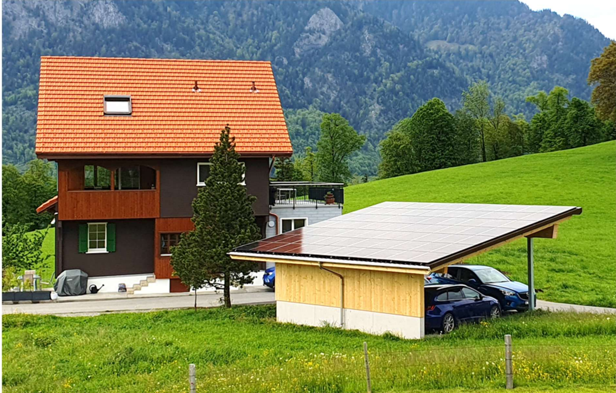
2er Carport mit PV-Anlage
